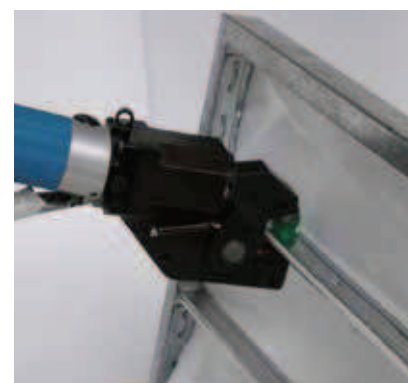
Conducto de ventilación
