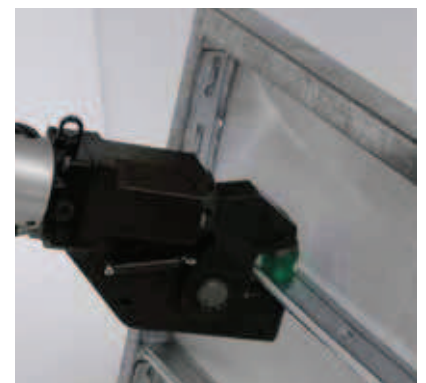
Abertura de ventilación
